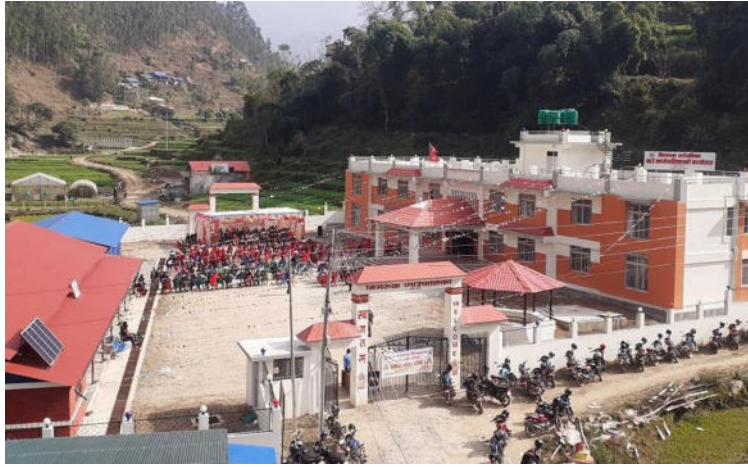
भिमरुक गाउँपालिका प्यूठानको आफ्नै प्रशासनिक भवन।
